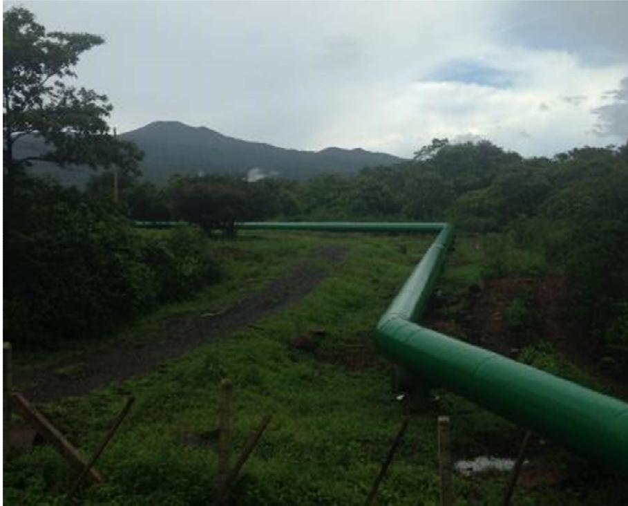
*Las tuberías que conducen el fluido geotérmico hacia la planta han sido pintadas en color verde para reducir el impacto visual.*
