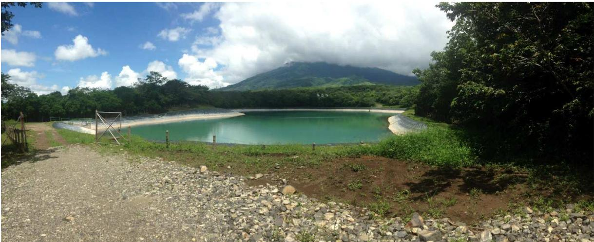
*Laguna de almacenamiento (y estación de separación al fondo) prevista como purga durante las pruebas de los pozos y como laguna de recolección de condensados*
