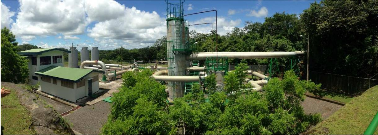
*Estación de separación de las fases líquida y de vapor del fluido geotérmico extraído*
