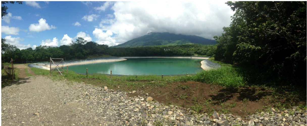
Lagune de stockage (et station de séparation en arrière-plan) prévue comme exutoire lors des essais de puits et comme bassin de recueillement des condensats
