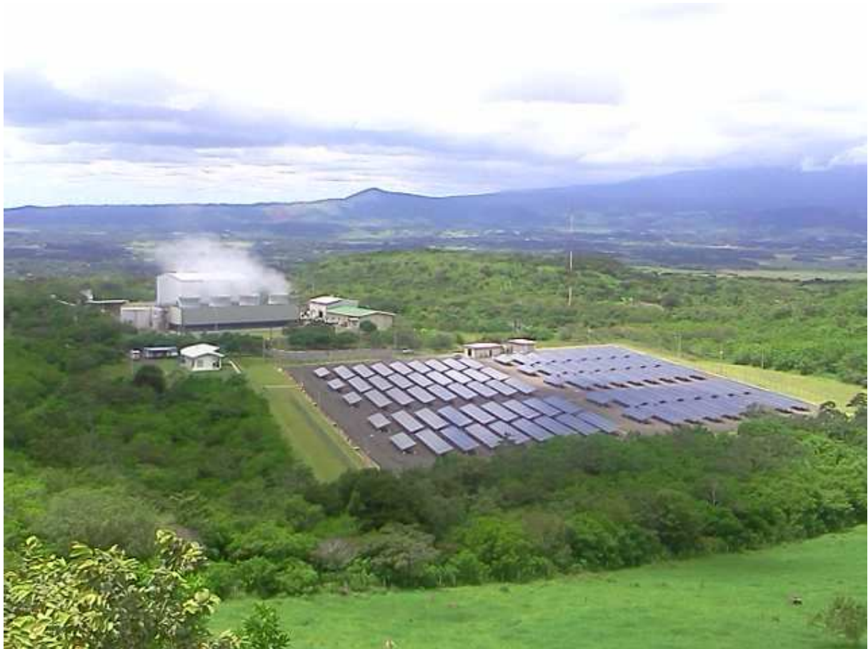
Vue sur la centrale géothermique de Miravalles III (30 MW) avec, devant, une centrale solaire photovoltaïque de 1 MW. En arrière-plan, au loin et sur la crête, un champ d'éoliennes.
