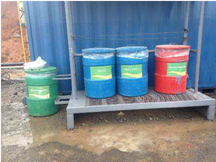
Tri des déchets sur le site
