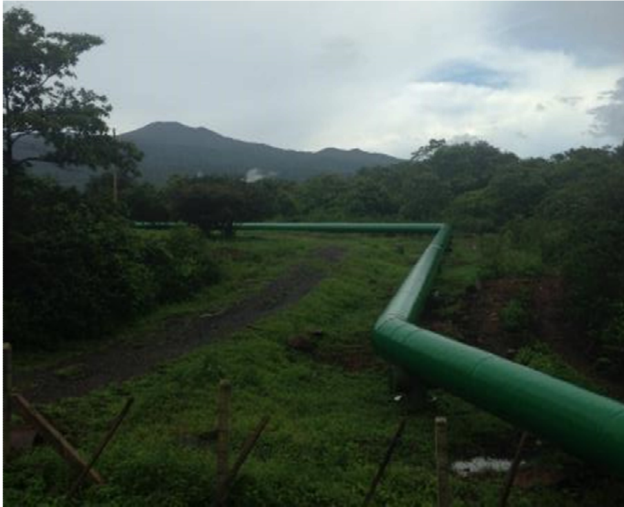
Les conduites d'amenée du fluide géothermal vers la centrale ont été peintes en vert afin de réduire l'impact visuel.
